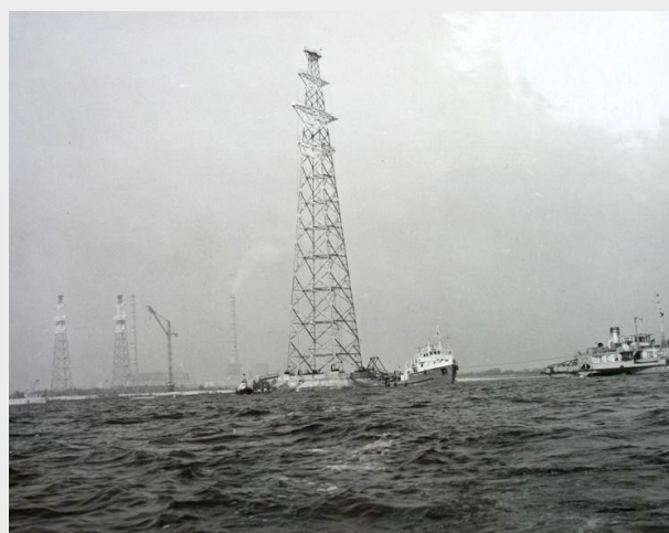
Des supports de lignes électriques furent construits sur la rive, puis remorqués jusqu'aux sites d'installation dans le réservoir de Kakhovka. Source de l'image : Fournie à partir d'une archive privée.
