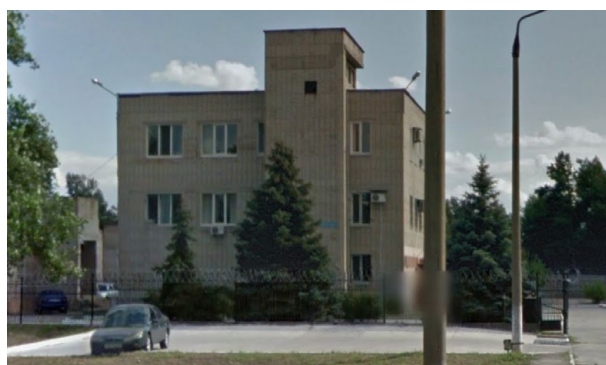
Le bâtiment du SBU à Enerhodar. Source de l'image : Google Maps.
