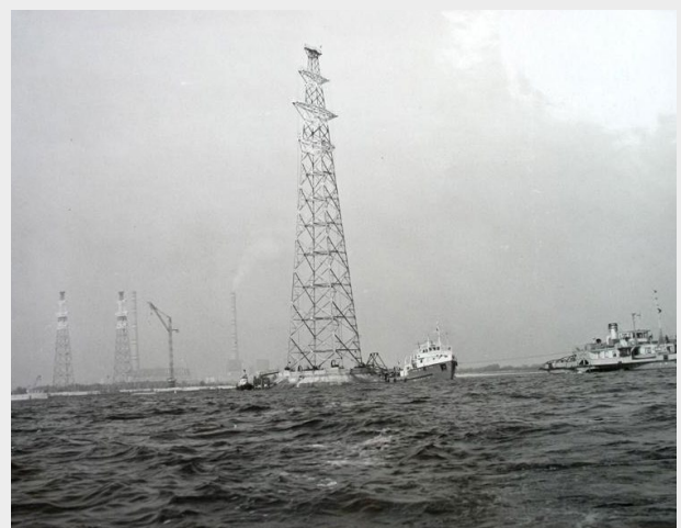
Die Stromleitungsträger wurden an der Küste gebaut und anschließend zu den Installationsorten im Kachowka-Stausee geschleppt. Bildquelle: Aus einem privaten Archiv.
