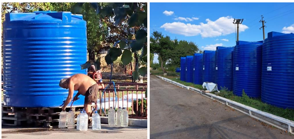
Réservoirs d'eau pour les communautés affectées à Kapulivka (à gauche) et Nyva Trudova (à droite), Dnipropetrovsk Oblast. Source : photo prise par les chercheurs de TH et PEJ sur le terrain
