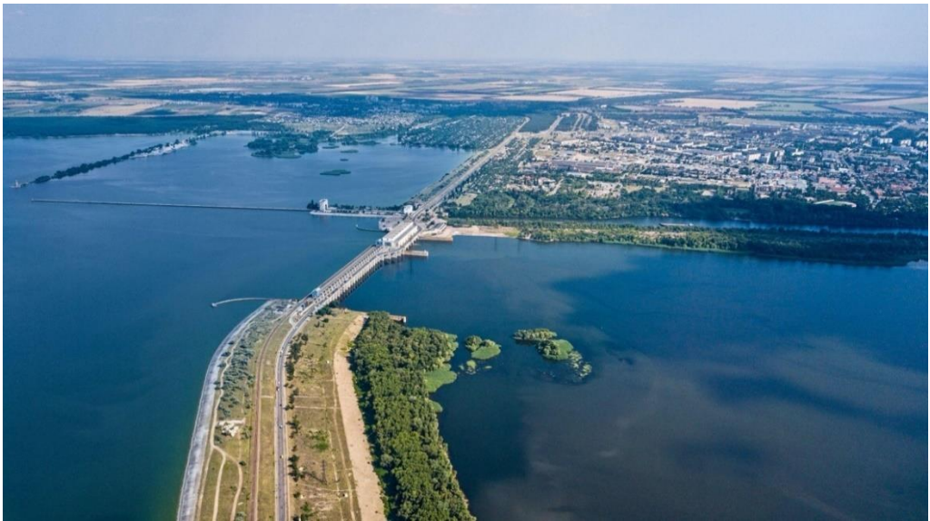
Complexe hydroélectrique de Kakhovka. Vue aérienne. Source : Ukrhydroenergo 25
