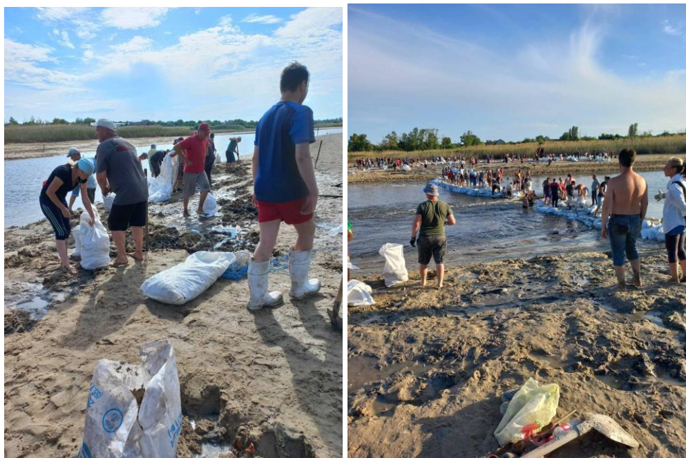
Construction d'un barrage auto-improvisé par les habitants, Kapulivka et Oleksiivka, région de Dnipropetrovsk, juin 2023. Source : photo prise par les chercheurs de terrain de TH et PEJ
